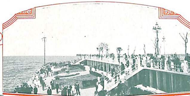
EL ESPICION DEL BAÑEARIO MUNICIPAL, HA PERMITIDO CON ESTE, ARREBAATAR A LAS ACTIVIDADES FERRO-PORTUARIAS, BUENA PARTE DE LA RIBERA DEL PLATA, Y BUENOS AIRES PUDO ASI, DAR A SU PUEBLO, SOLAZ Y ESPARCIMIENTOS, DE QUE CARECIA.
